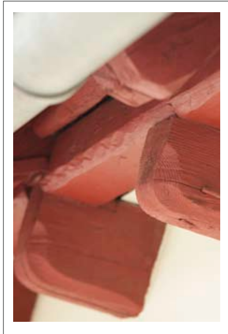
Fragment wsporników dachowych
