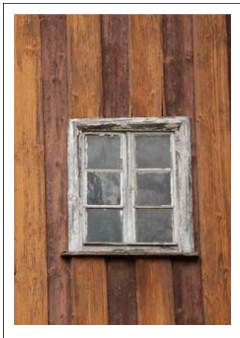
Stolarka okienna z oszalowaniem szczytu
