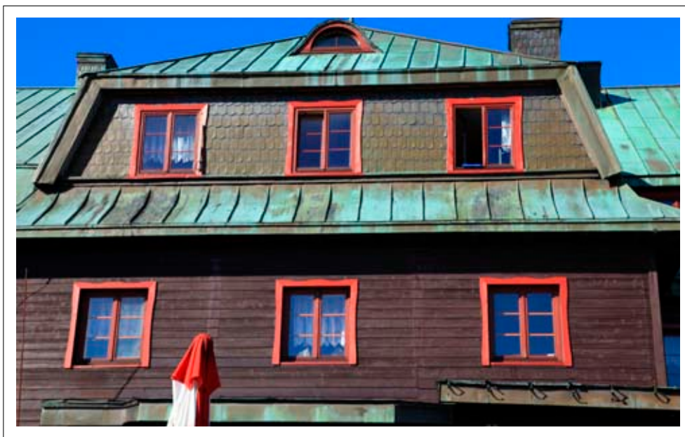
Detal elewacji – deskowanie poziome
