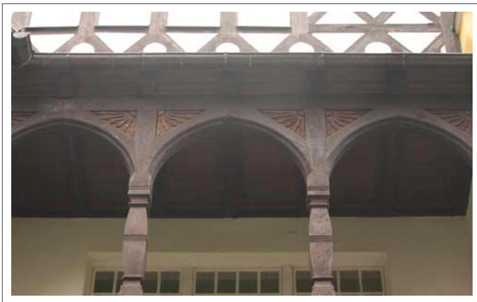
Loggia w elewacji północnej
