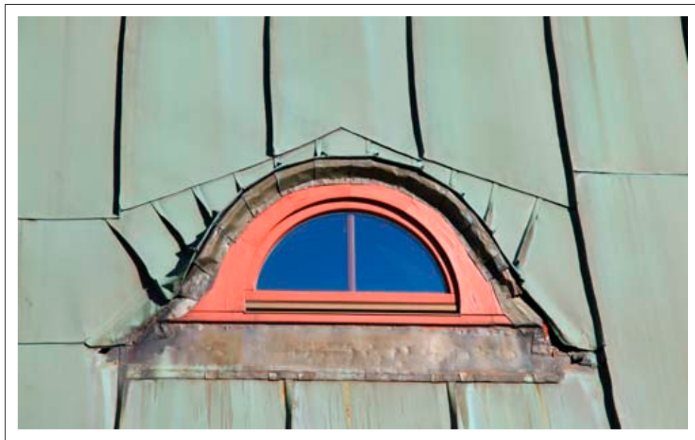
Detal – „wół oko” w połaci dachowej
