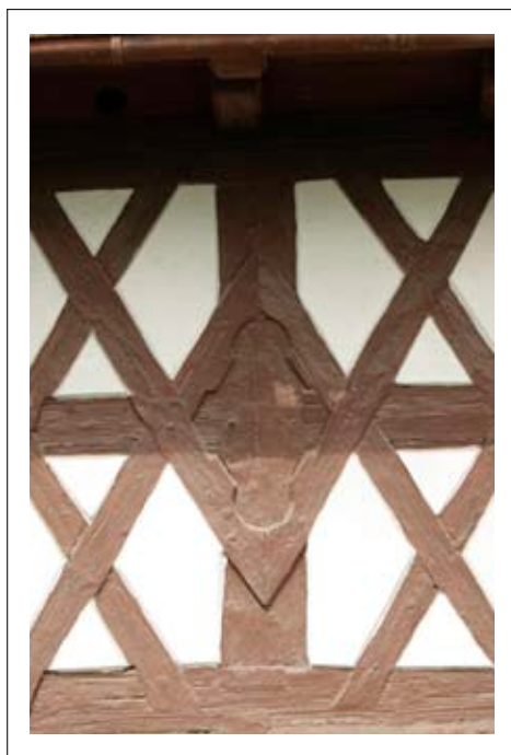
Dekoracyjne rozmieszczanie detalu konstrukcji ryglowej
