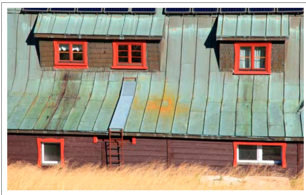
Detal pokrycia dachu – blacha w rąbek oraz daszkipulpitowe nad lukarnami
