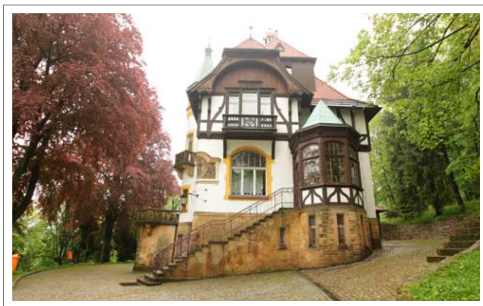
Widok elewacji zachodniej
