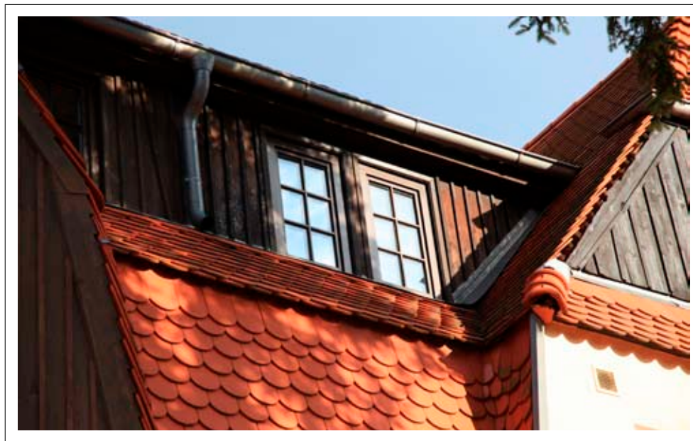
Mansardowy dach z facjatkami
