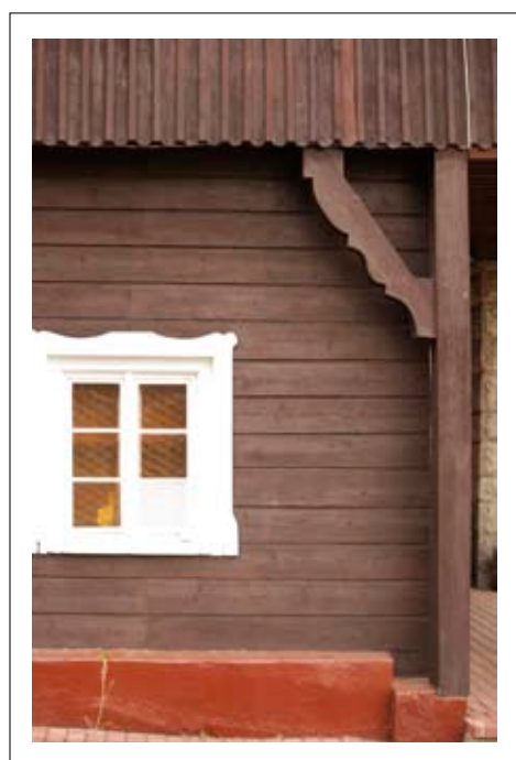
Konstrukcja drewniana przysłupowa
