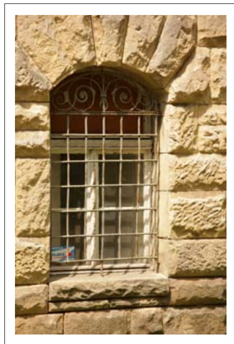
Detal - okno obudowane kamiennym boniowaniem oraz krata kuta
