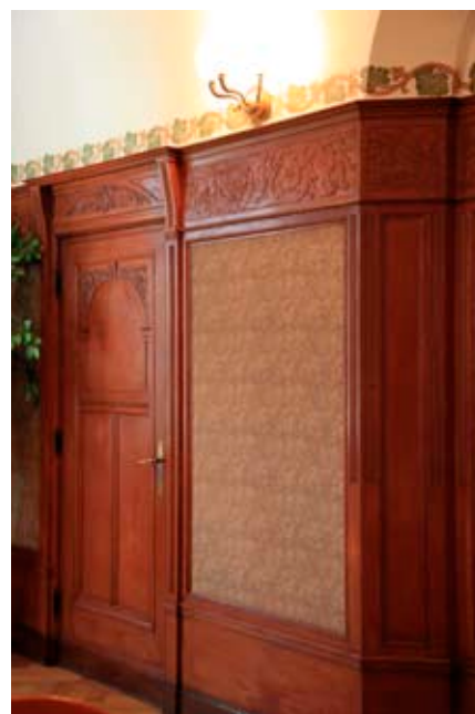
Stolarka drzwiowa z boazerią wypełnioną barwioną tapicerią
