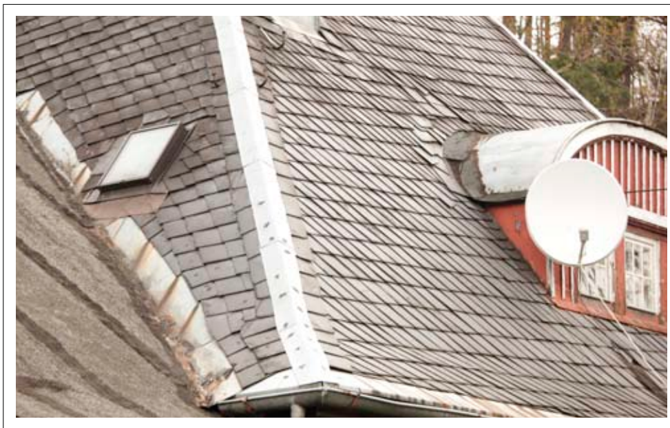
Budynek „Pod Skałką” przy pętli Tramwajowej- pokrycie dachowe- łupki
