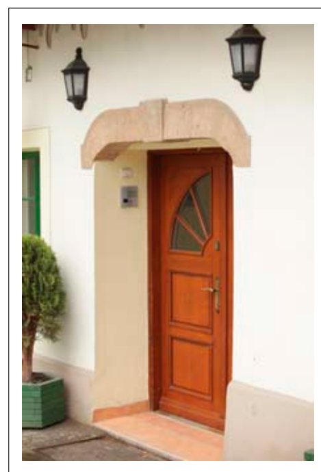
Portal wejściowy i fragment stolarki drzwiowej
