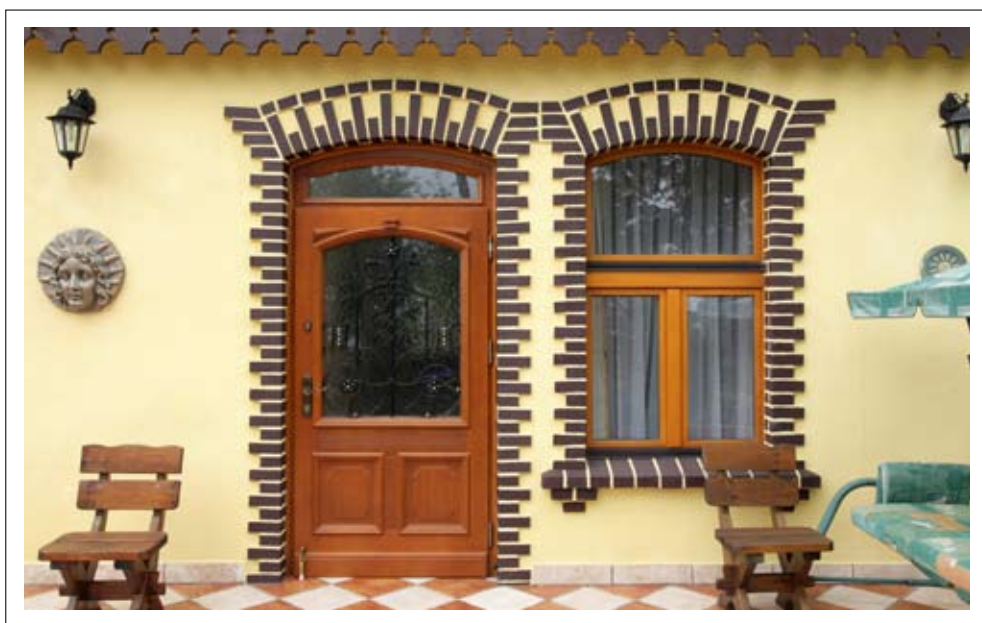
Obudowa okna wykonana przy użyciu cegły klinkierowej
