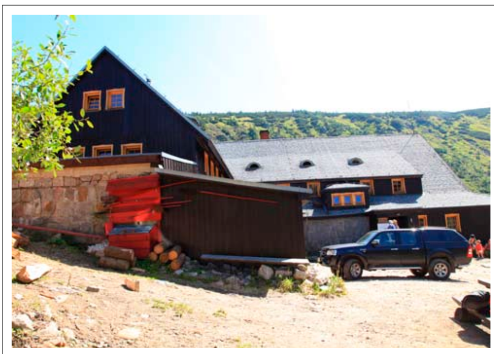
Zdjęcia elewacji bocznej
