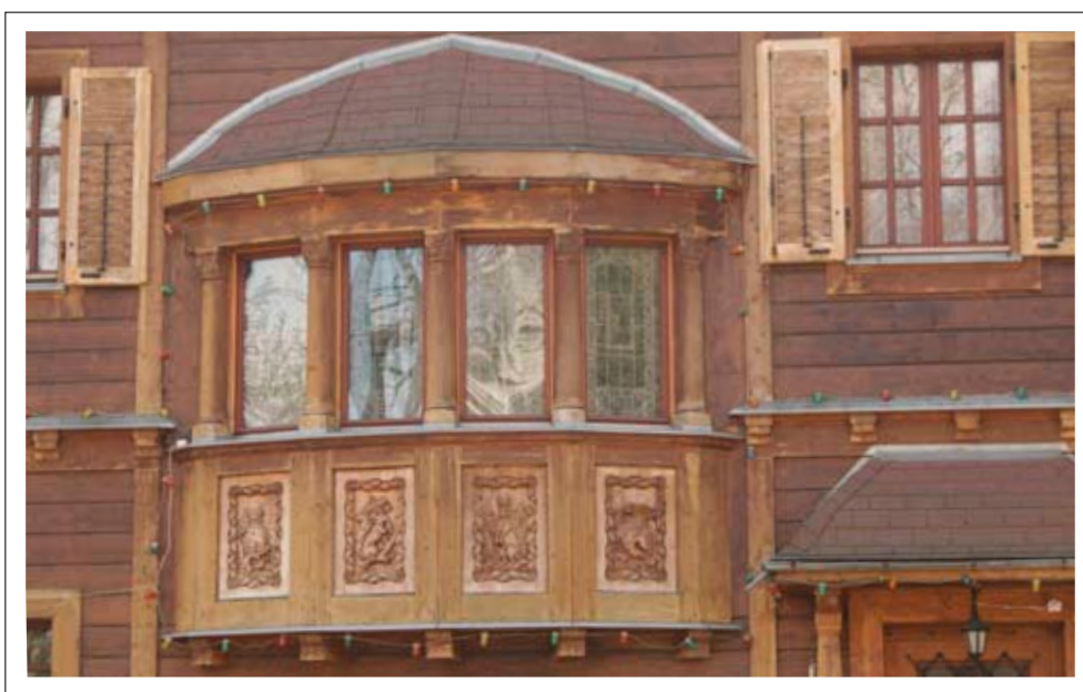
Fragmeny elewacji z drewnianym wykuszem
