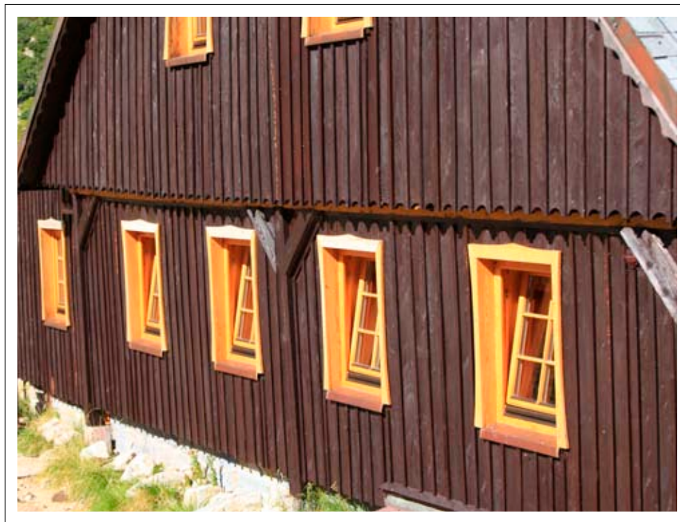
Elewacja szczytowa z widoczną konstrukcją przysłupową
