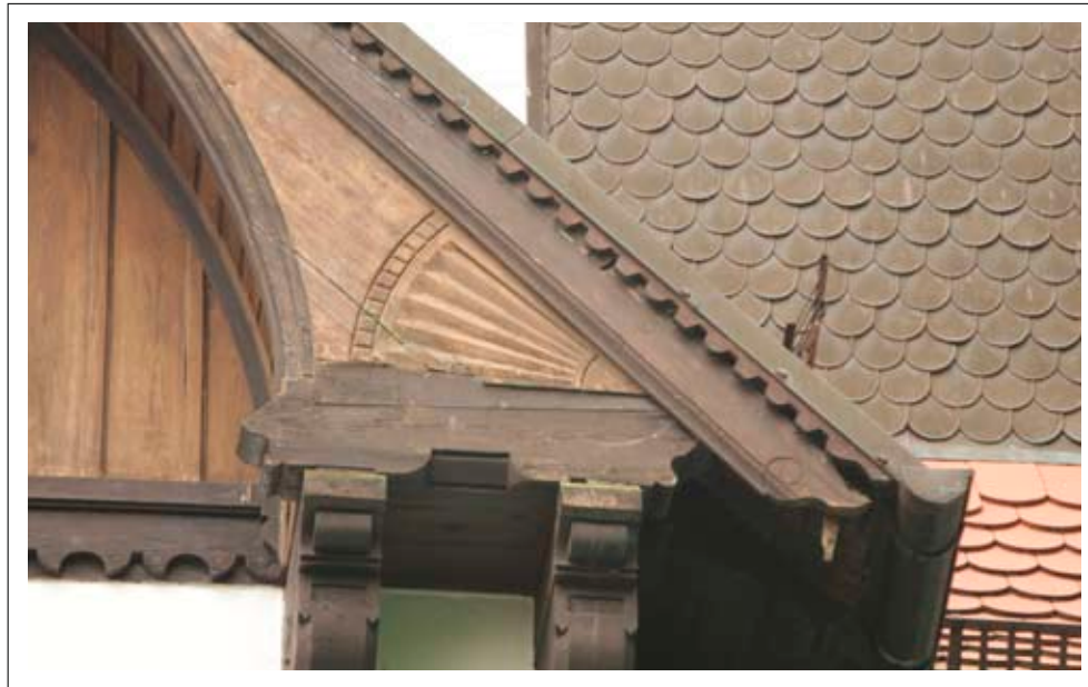
Detal krośztynów narożnika szczytu elewacji zachodniej
