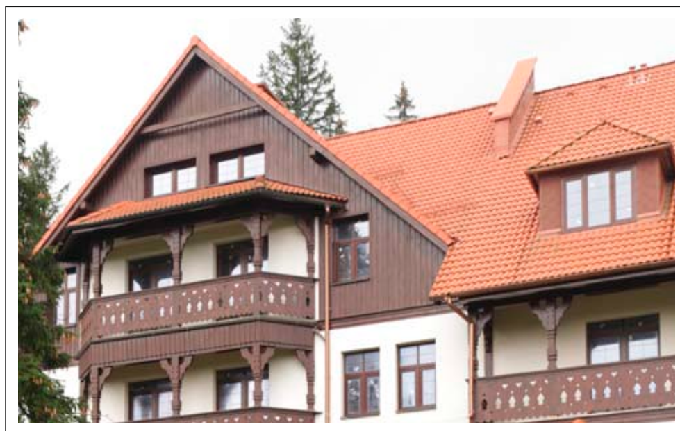
Balkony na elewacji frontowej
