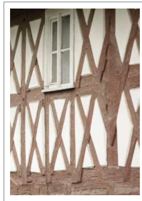
Widok perspektywiczny na konstrukcję ryglową piętra
