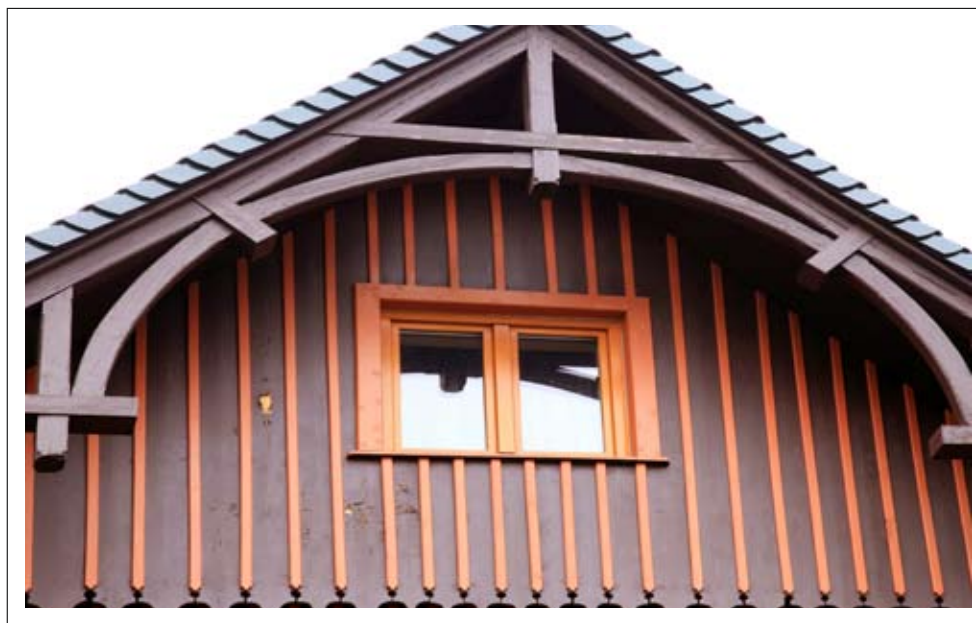
Detal ściany szczytowej
