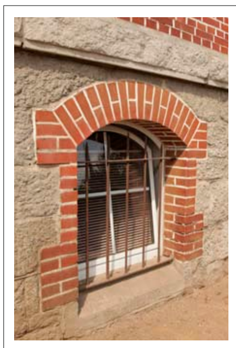
Okno piwniczne - obramowanie
