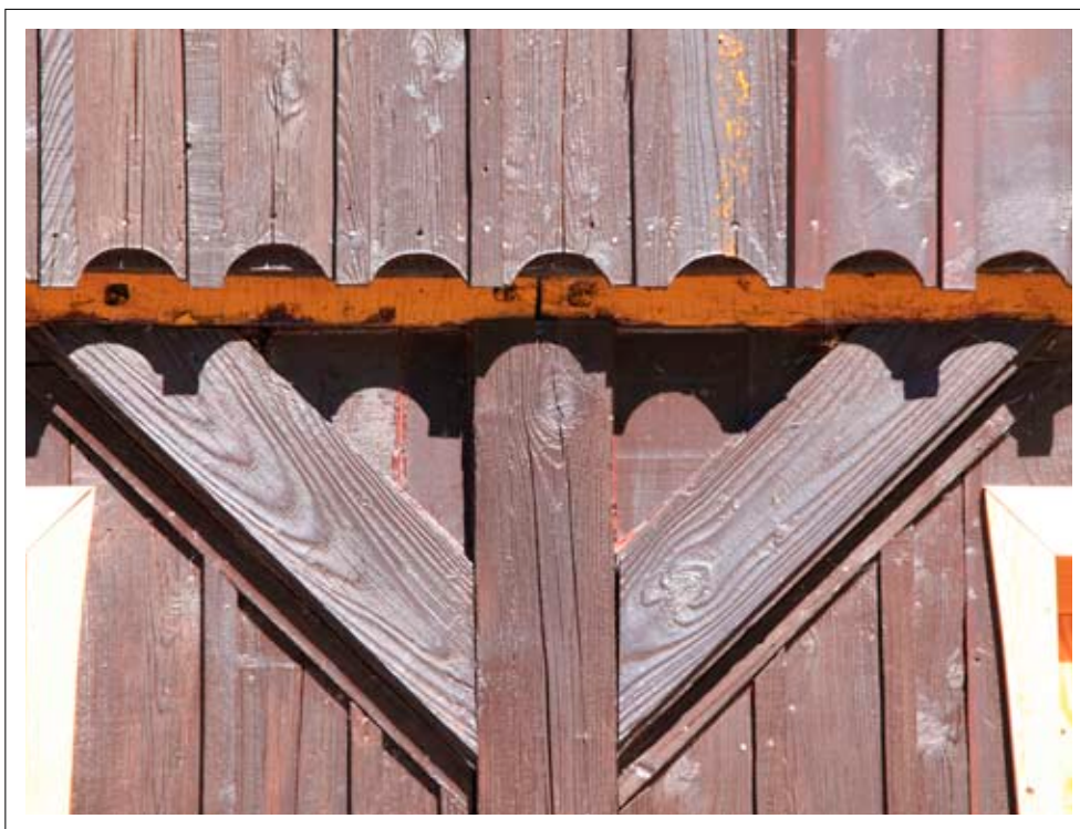
Słup z mieczami oraz widoczne zakończenia odeskowania
