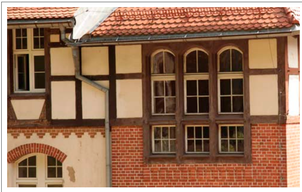
Fragment ściany o konstrukcji szkieletowej
