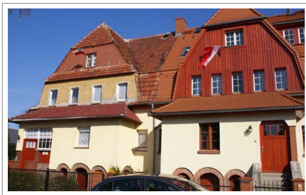
Elewacja frontowa od nr 6-8
