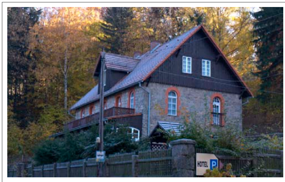
Widok budynku towarzyszącego-mieszkalnego
