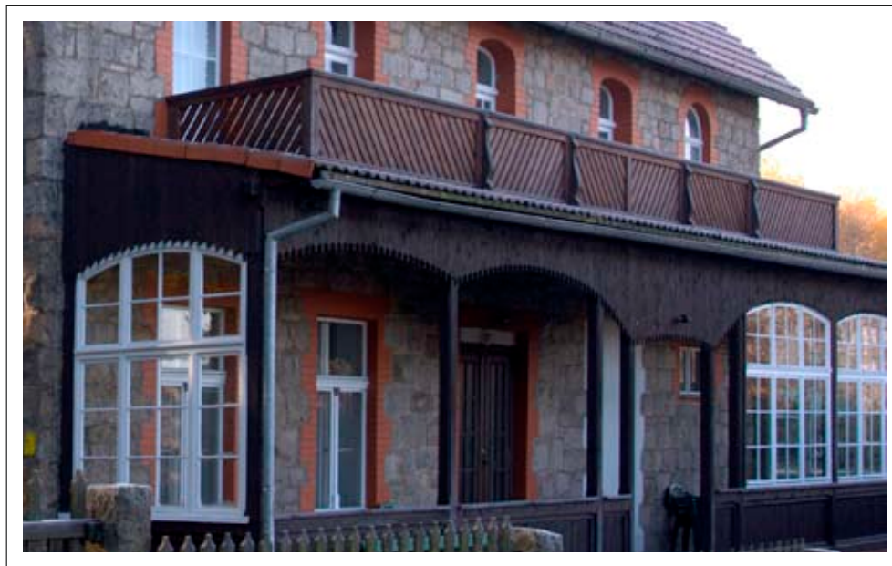
Budynek towarzyszący – elementy drewniane weranda oraz balkon
