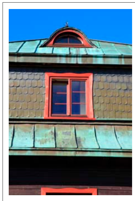
Detal okna lukarny
