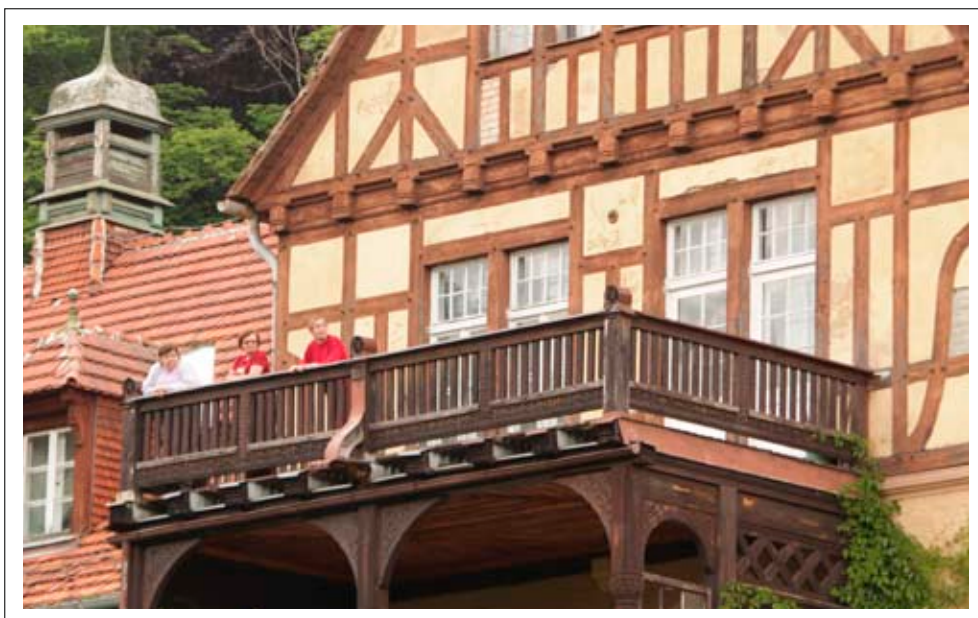
Detal - drewniane balustrady balkonów
