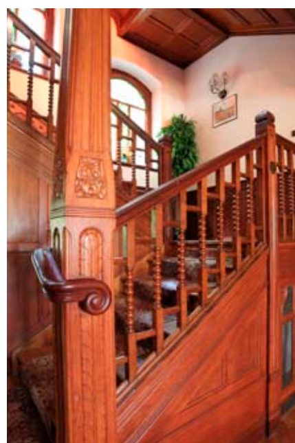
Balustrada klatki schodowej
