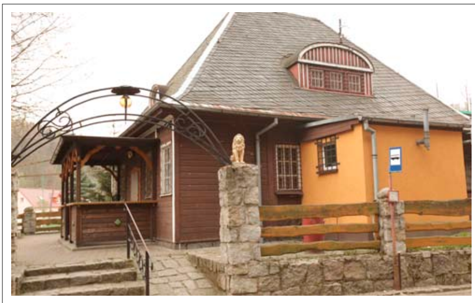
Widok elewacji bocznej, strefa wejściowa
