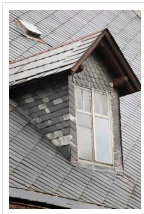
Szczyt opierzony łuską wykonaną z balaitowego łupka
