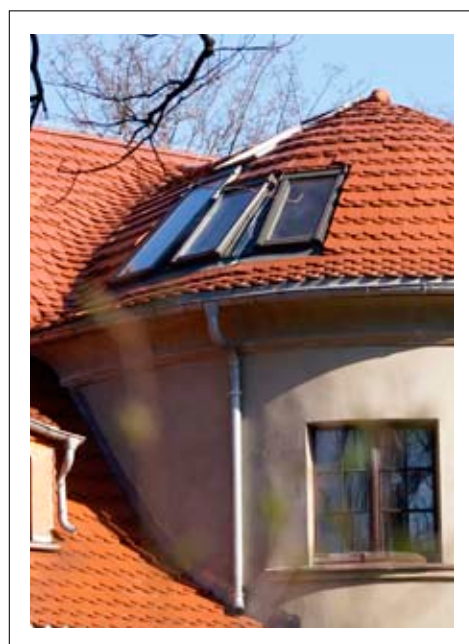
Budynek dawnego przedszkola przy ul. Cervi w Cieplicach – doświetlenie oknami połaciowymi
