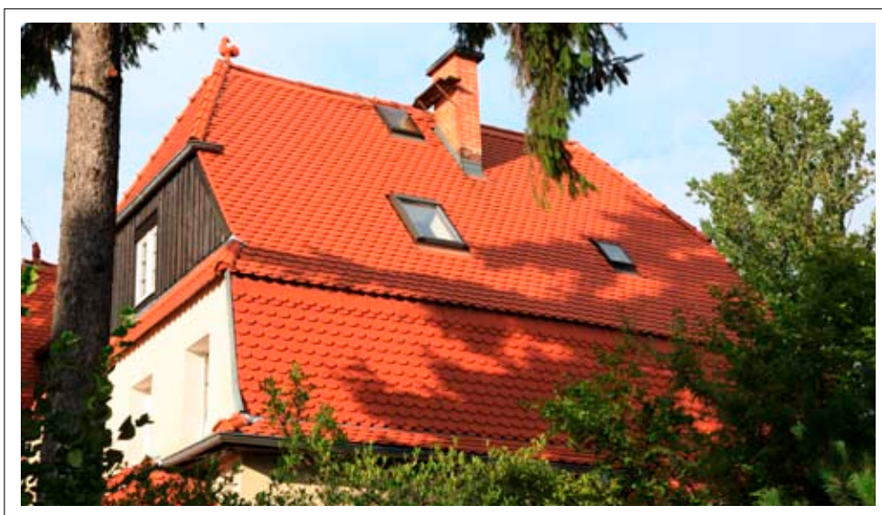
Zakopiańska nr 12 – widok na boczne połacie dachu
