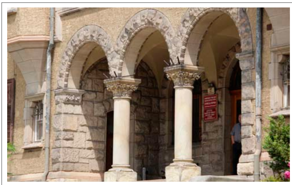
Strefa wejściowa – sklepienie łukowe wsparte na kolumnach
