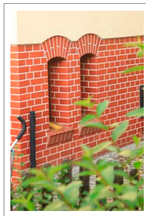
Bliźniacze okna piwnicy
