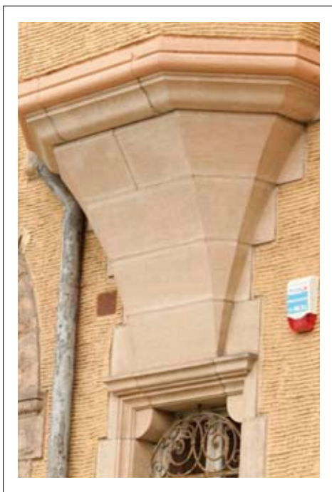
Detal elewacji – kamieniarka z piaskowca podtrzymująca wykusz
