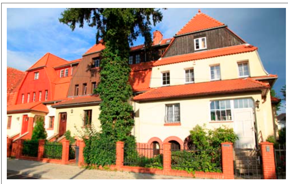
Elewacja frontowa od nr 8-12
