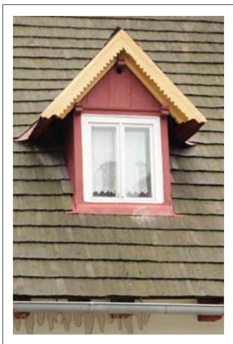
Facjatka dachowa – pokrycie gontowe
