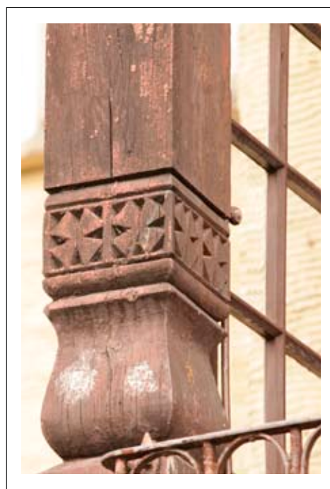
Baza kolumny drewnianej
