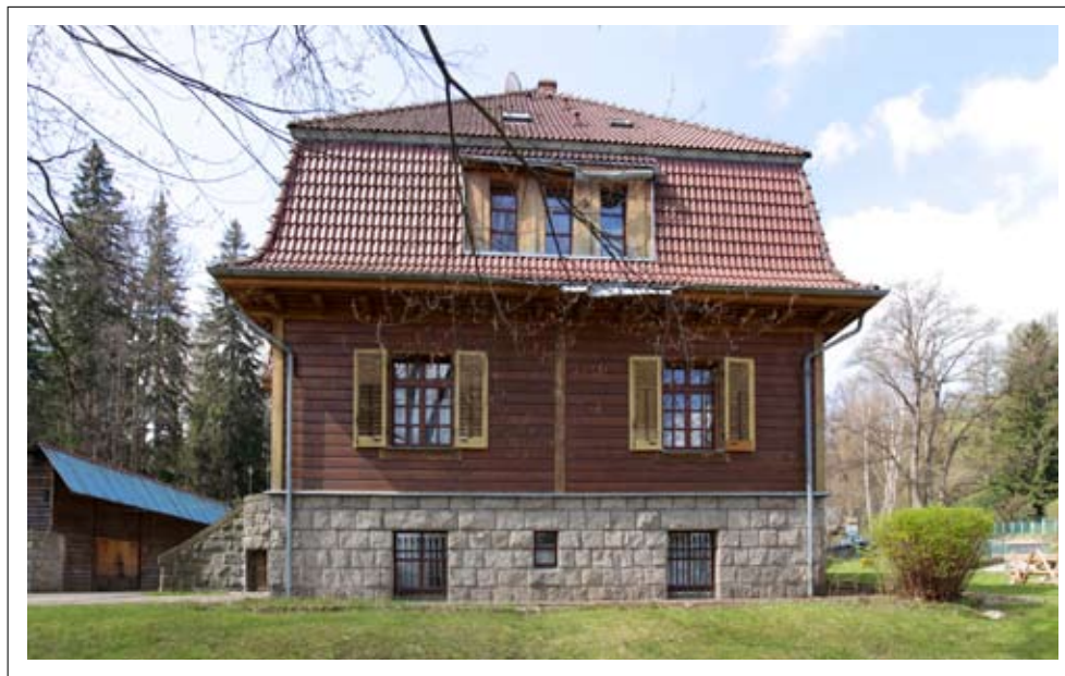
Elewacja boczna – okna z okiennicami z ruchomymi żaluzjami
