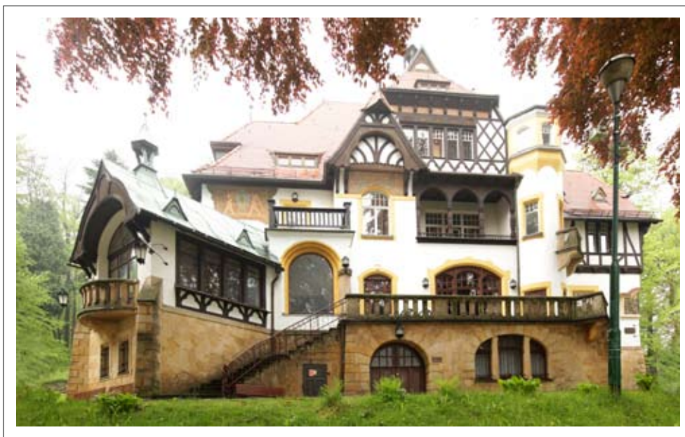
Widok elewacji północnej
