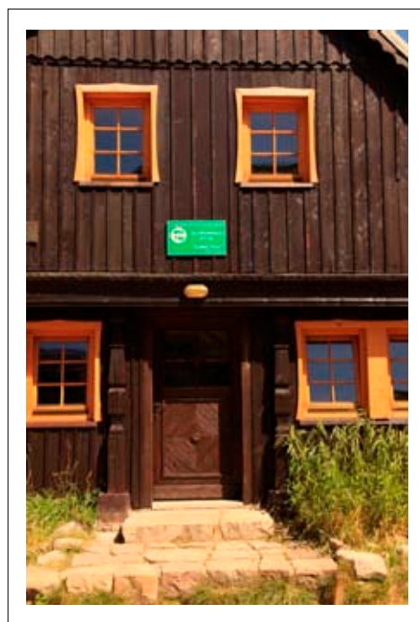
Wejście w elewacji frontowej
