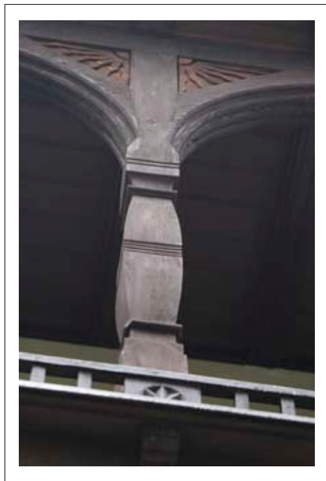
Snycersko opracowany detal drewnianych loggii
