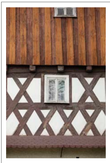
Konstrukcja ryglowa piętra
