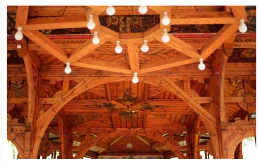
Zdjęcia detali wnętrza: polichromie i rzeźbione detale – snycerka stropu
