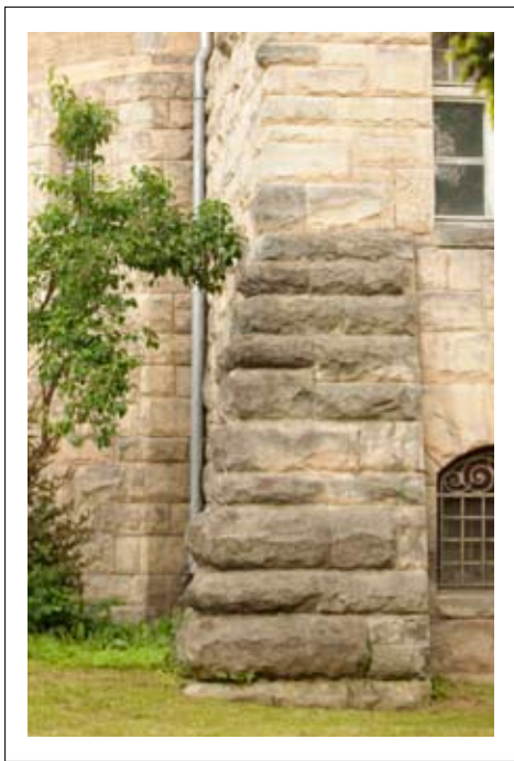
Detal - cokół wykonany z piaskowca imitujący boniowanie
