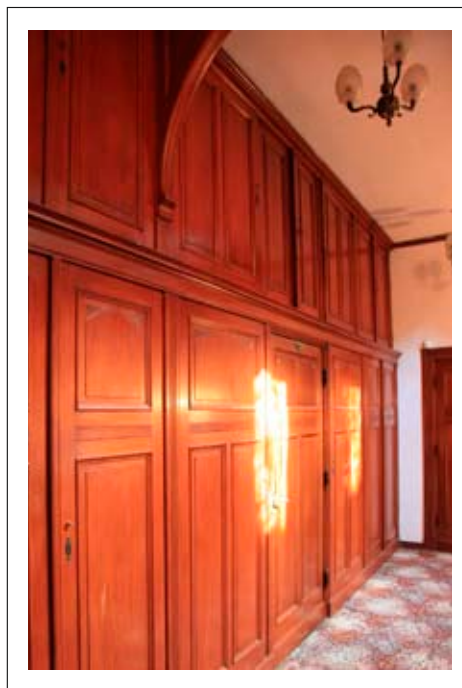
Szafy ścienne wkomponowane w wystrój pomieszczenia
