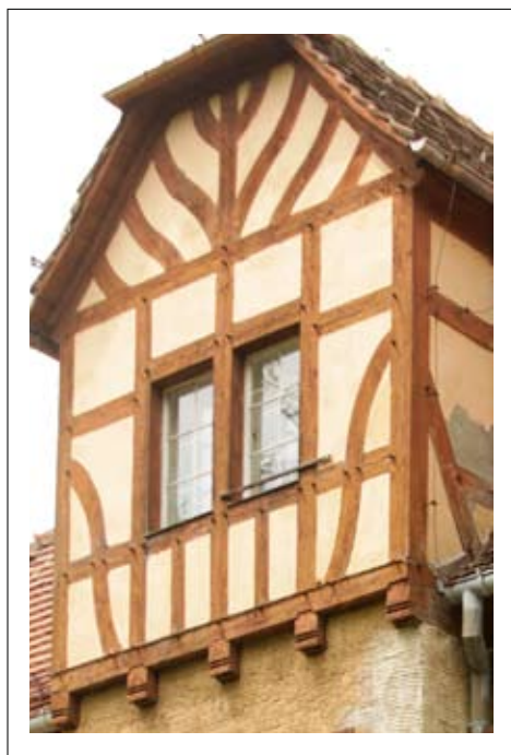
Detal - elewacji- szachulec – konstrukcja ryglowa
