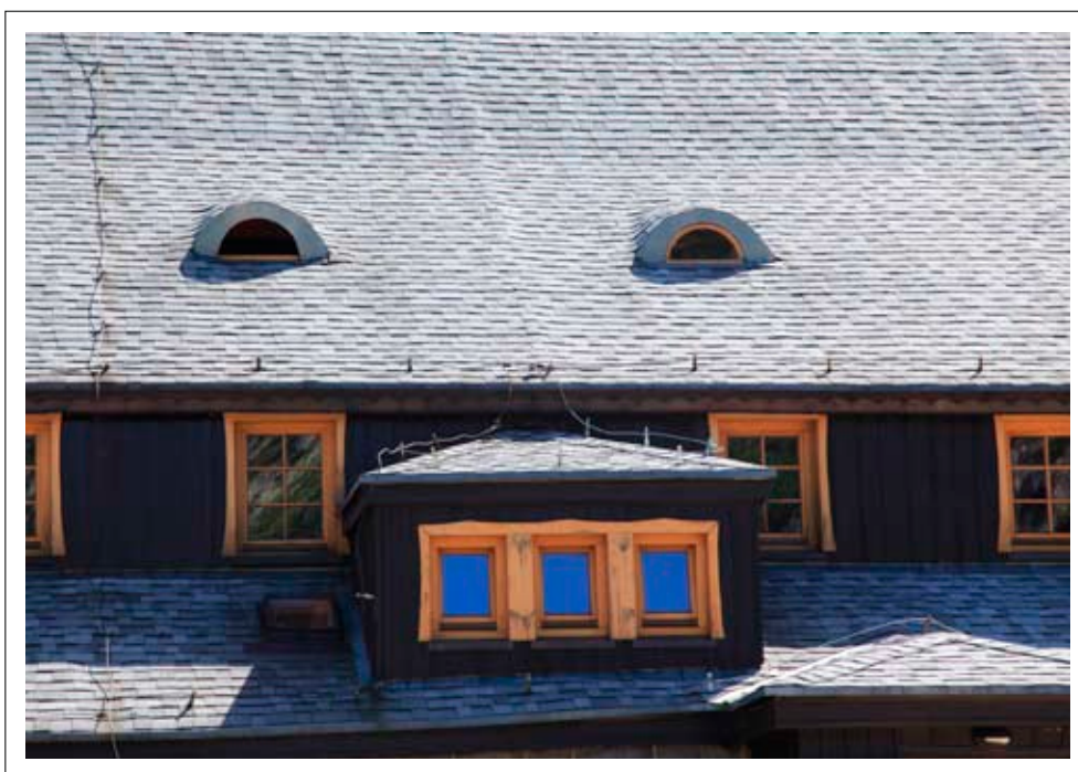
Połacie dachowe pokryte gontem
