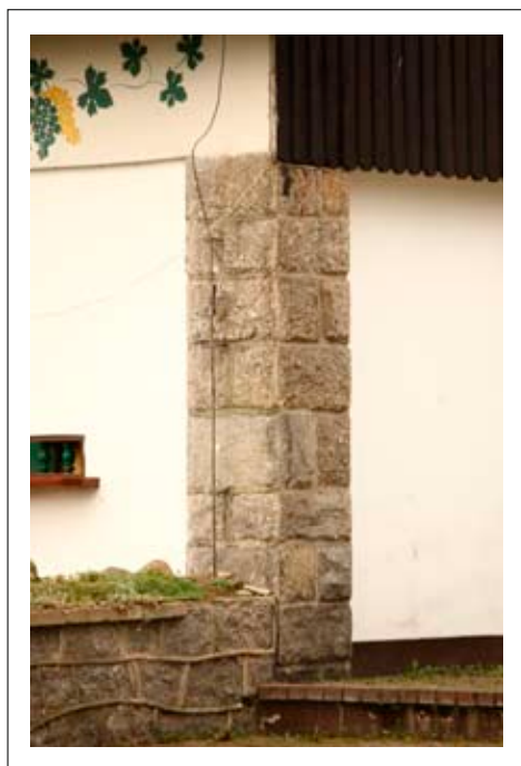
Detal elewacji – pilastry obudowane w granicie
