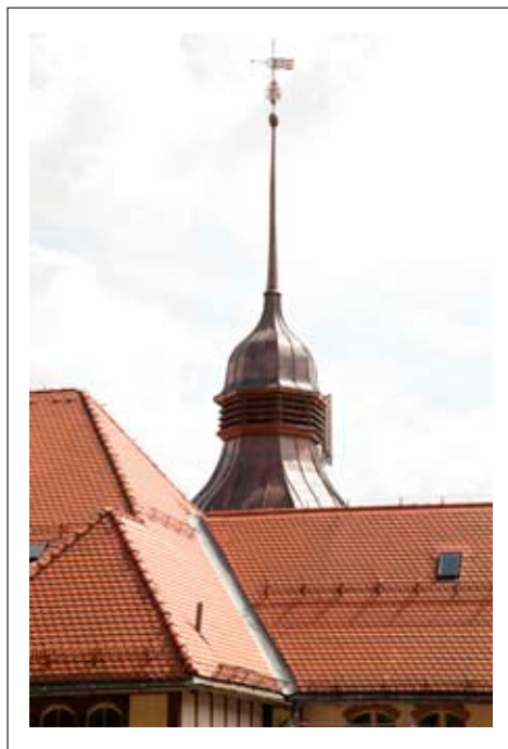
Dach z widokiem na kopułę wieży
