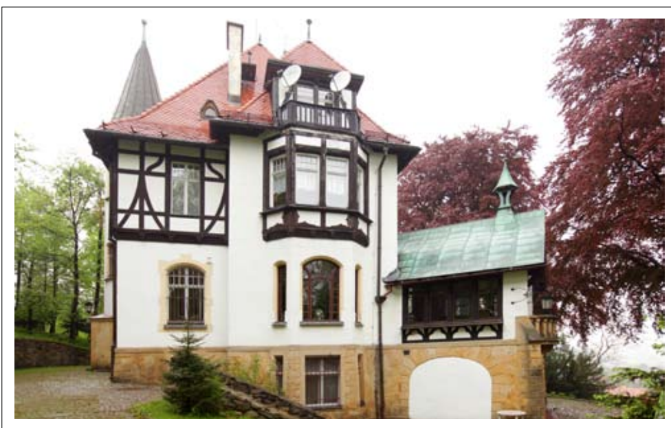
Widok elewacji wschodniej
