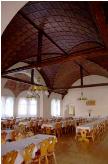
Widok wnętrza obiektu - jadalnia, sklepienia obudowane drewnianymi kasetonami (il. nr 37)
