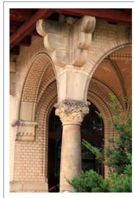
Kroksztyny podtrzymujące balkon nad podcieniem arkadowym
