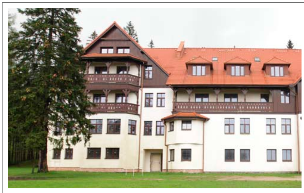
Fragment elewacji frontowej z widokiem na drewniane balkony
