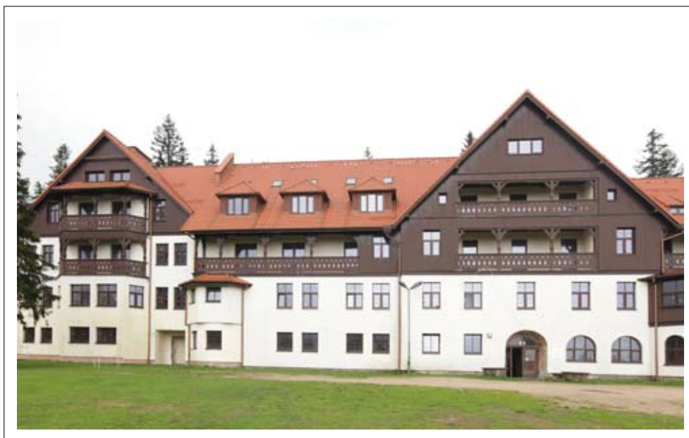
Fragment elewacji z balkonami
