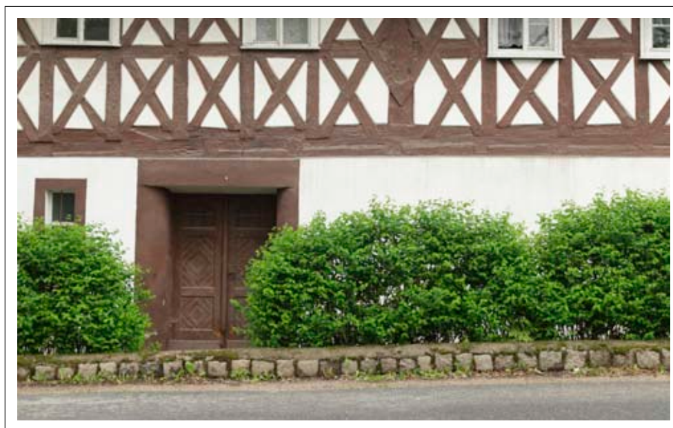
Fragment fasady z portalem i konstrukcją ryglową piętra
