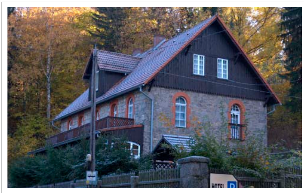
Budynek mieszkalny w Sosnówce - elewacja wykonana z kamienia granitowego, opaski okienne z cegły klinkierowej, deskowanie w górnej części
