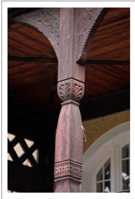
Kolumna drewniana podpierająca poziom balkonów zdobiona snycerką
